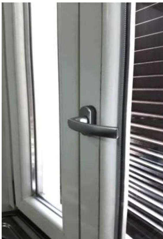
Profilo classe "A" a 5 camere con larghezza del telaio 76 mm. Una grande camera con acciaio ottimizzato tecnicamente garantisce un ottimale isolamento termico (1,1 W/m<sup>2</sup>K conformemente a DIN 52619) e acustico (fino a 47 dB ).
