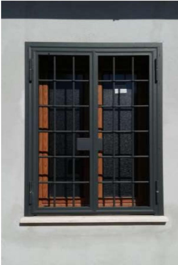
Grate di *sicurezza* con quadrello di ferro da 14 mm pre-zincate con verniciatura a polvere epossidica
